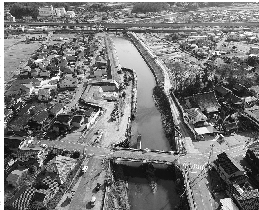
流域治水対策で拡幅工事を行っている森下川(金沢市)
