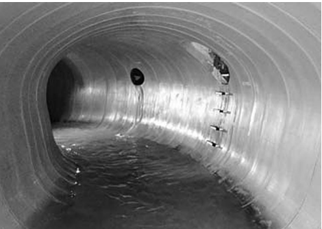
管更生工法(クリアフロー工法)
