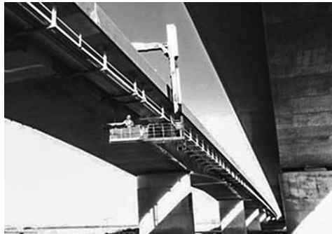
コンクリート表面剝離剝落対策工
