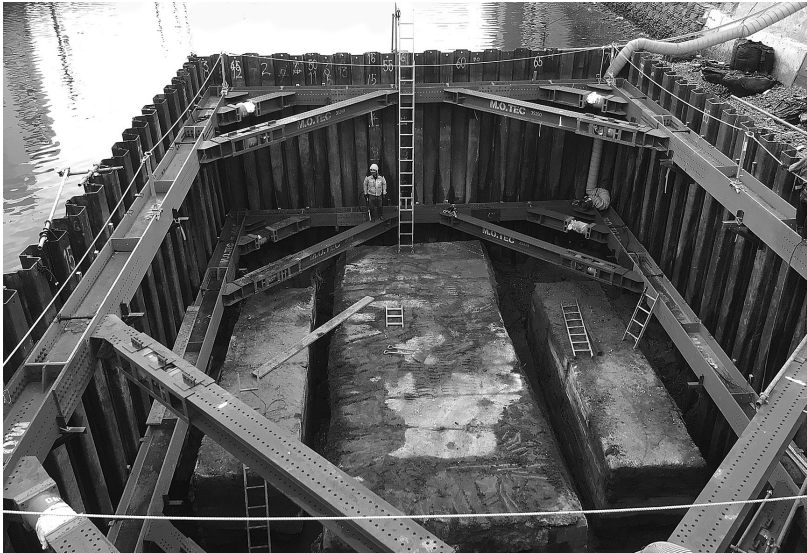
HS-beamの施工状況
