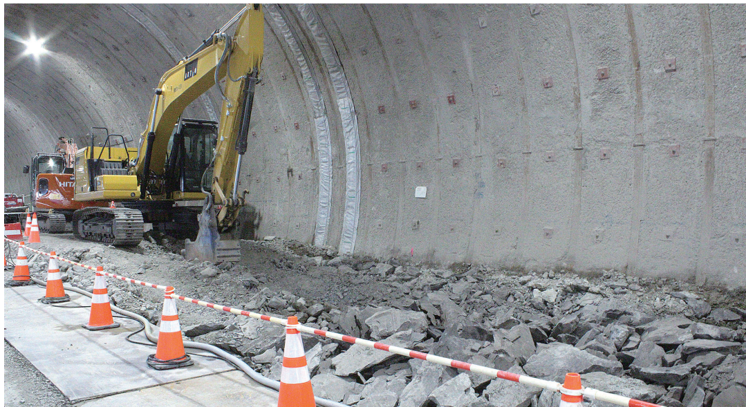
発破の点火場所と電源台車
