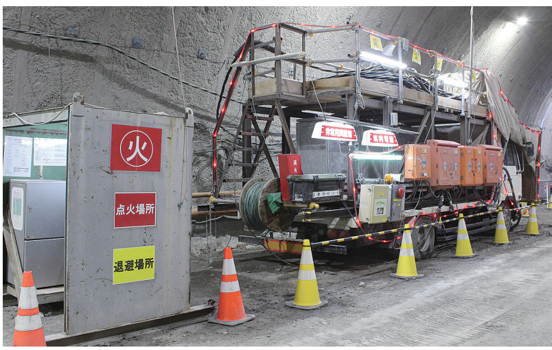
発破の点火場所と電源台車
