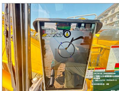
（マシンガイダンスによる操作状況）
