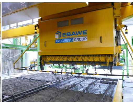
コンクリート打設
