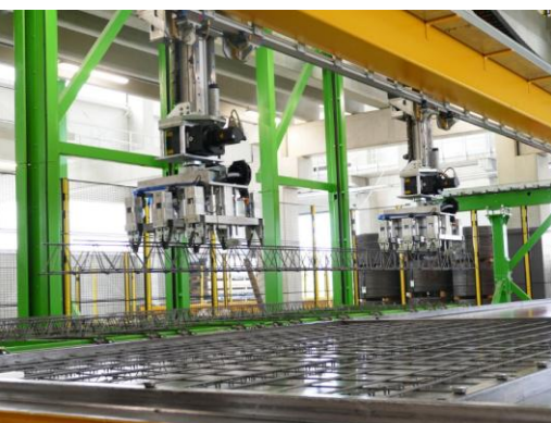
トラス筋設置
