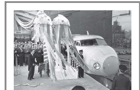
私が金網工務店を引き継いだのは1964年、東海道新幹線が開通した頃である
