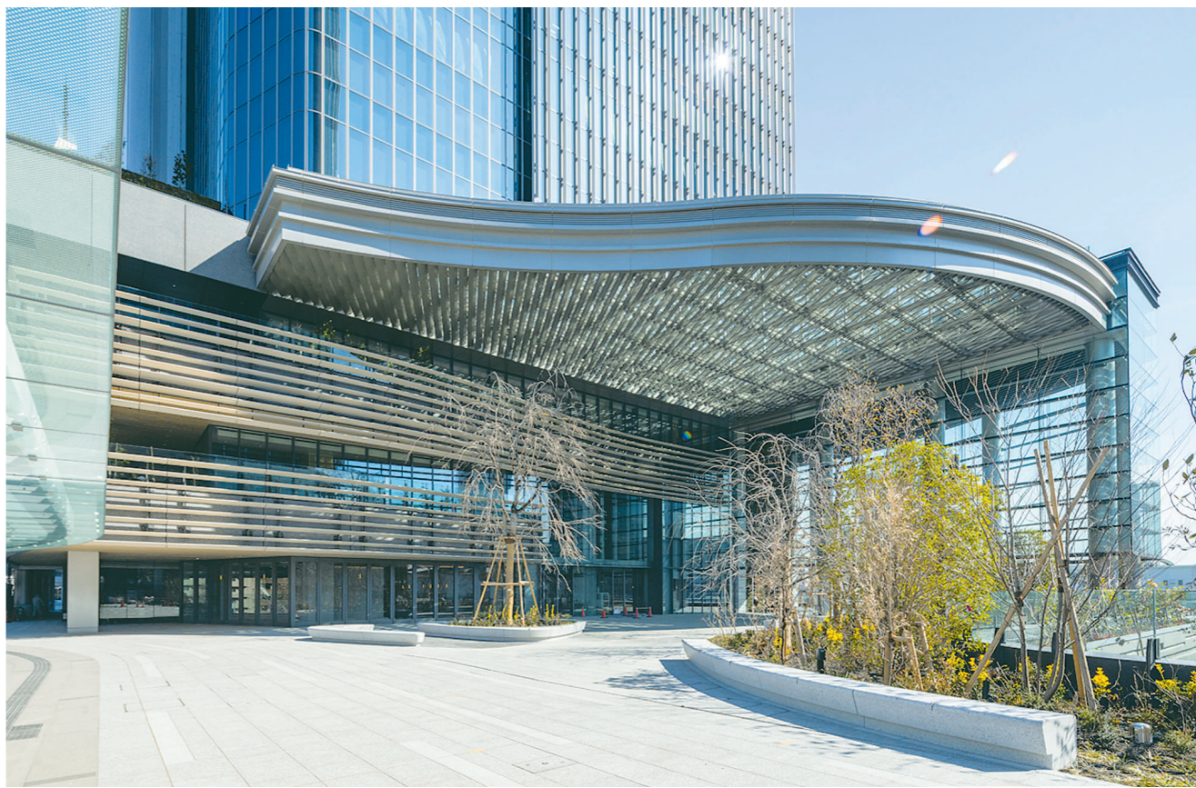
デッキ南広場
