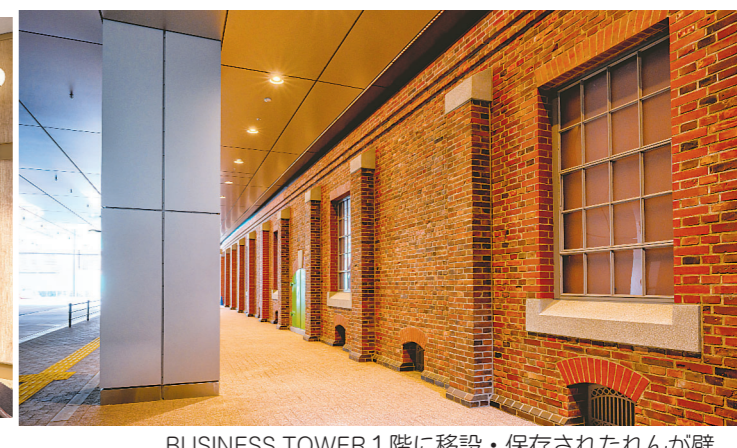
BUSINESS TOWER 1階に移設・保存されたれんが壁 (JR東日本提供)
