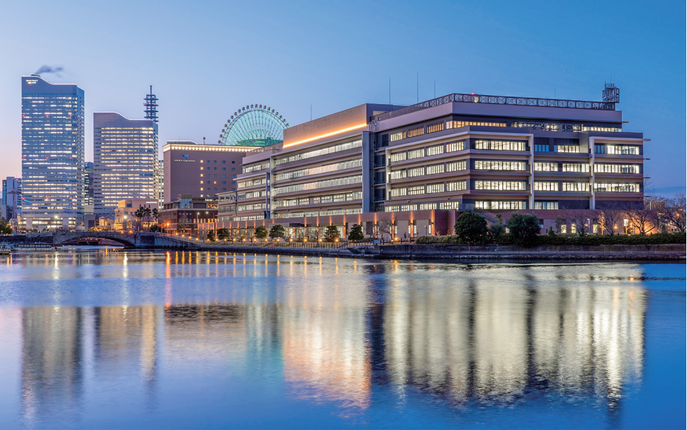
南東側外観 夜景
