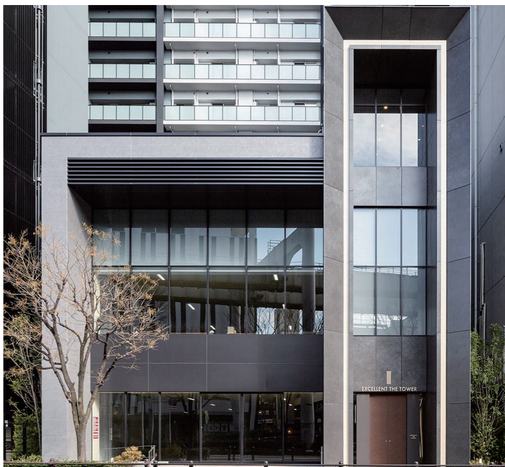
外観西面低層部
