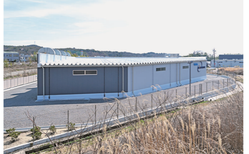
外観(北面から)
