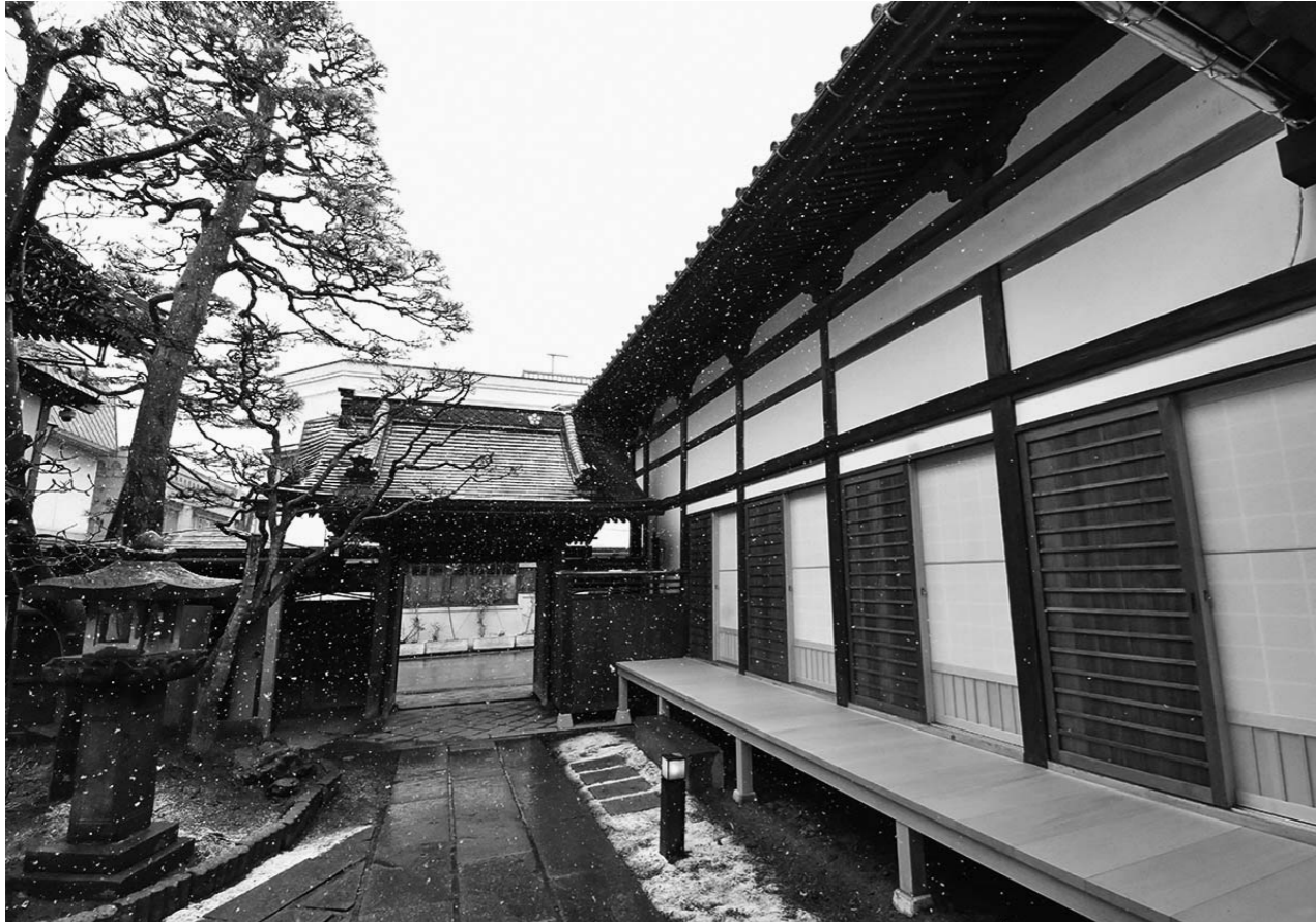
蓮華院小御堂の外観。縁側に面した開口部を舞良戸(まいらど)や障子に復元
