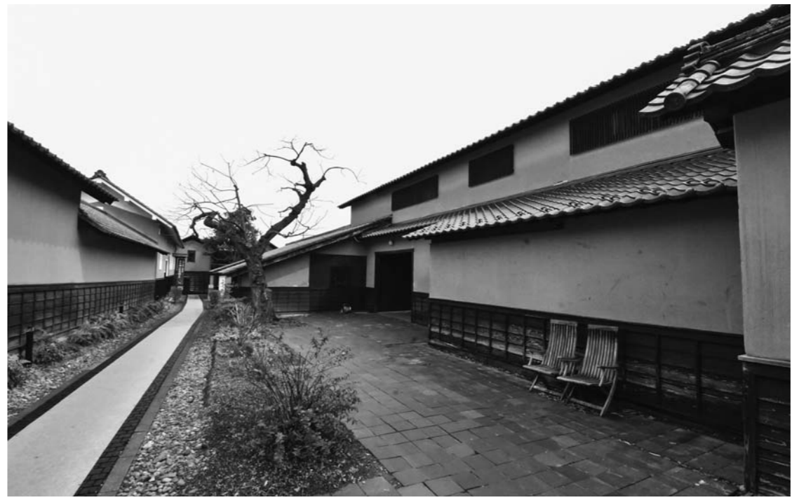
名産の栗の木を敷き詰めた小径は、地域に根差した土色の壁・瓦屋根の心地よいスケールの新旧建物で構成され、うるおいのある空間を醸し出す
