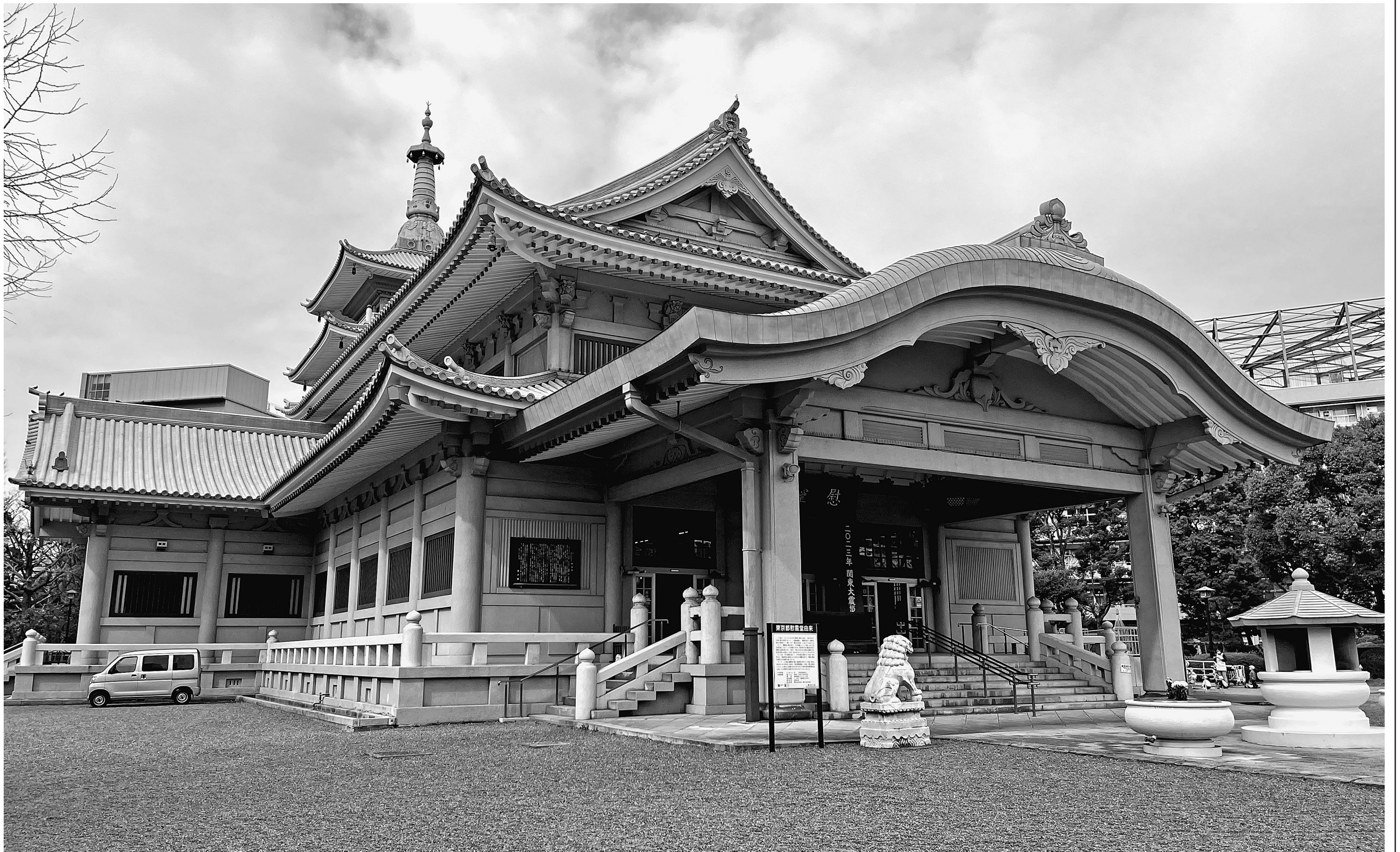
東京都慰霊堂（東京都墨田区横網2-3-25） 東京の防災のシンボルの建物。1923（大正12）年9月1日に発生した関東大震災の犠牲者を慰霊し、このような災害が二度と起こらないよう祈念するために建設された。1930年竣工。設計は伊東忠太が担当し、日本由来の宗教的様式を表現する建築とした。1999年東京都選定歴史的建造物。2013年3月から16年3月にかけて、耐震補強工事、外壁の美装化、銅葺き屋根の全面葺き替えなどのリニューアル工事を実施した。
