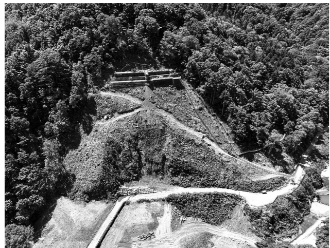
左岸頂部に設置した掘削用足場
