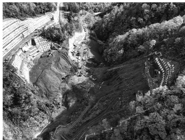
基礎掘削状況(下流から上流を望む)
