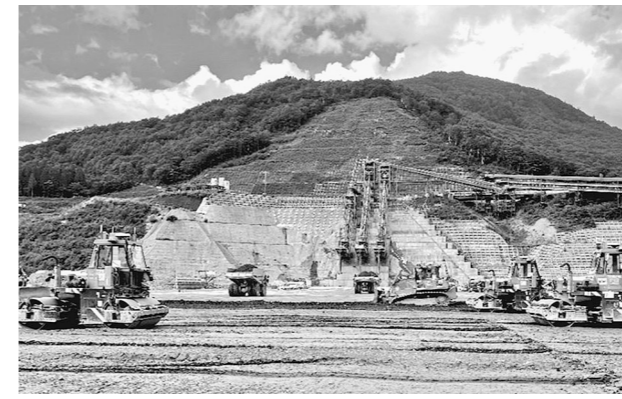
ダム現場の工場化（報道発表資料から）
