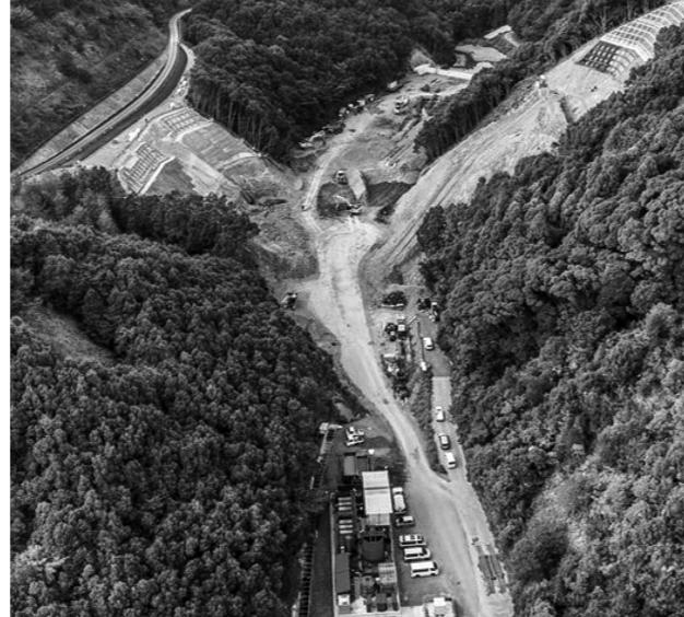
9月19日時点の現場状況
