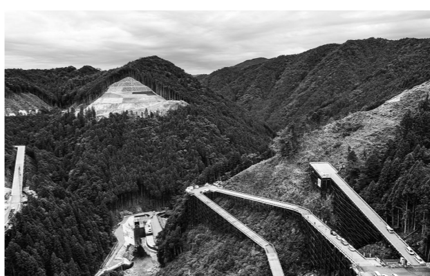
着工時全景(正面が左岸、中央下が堤外BP呑口)
