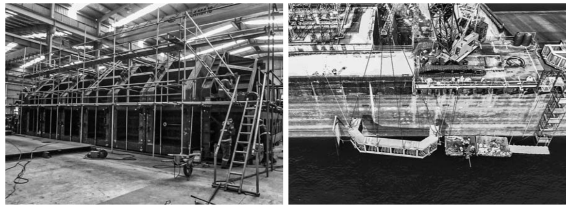
扉体の設置作業
