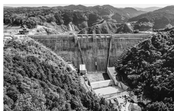
コンクリート打設が完了したダム堤体
