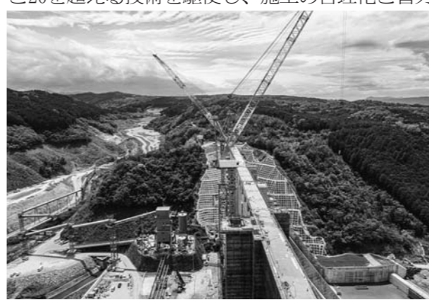
自律型タワークレーンで効率よくコンクリート打設
