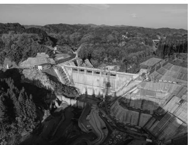
作業が進む現場の様子
