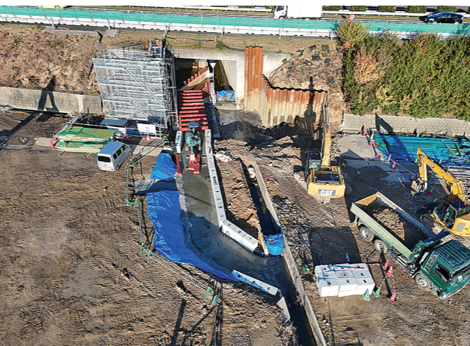
本線直下の半割施工(写真提供:安藤ハザマ・村上組JV)
