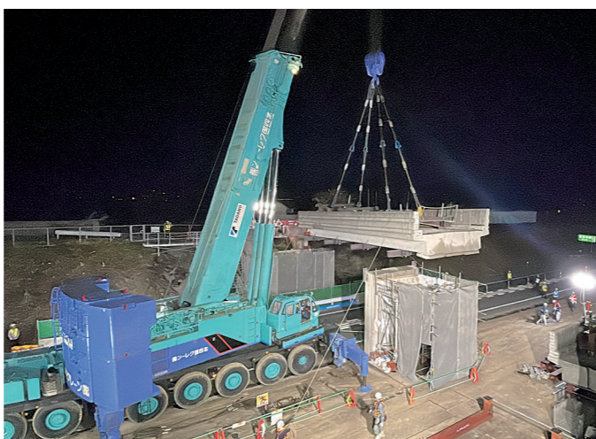
通行止めしての跨道橋撤去工事は時間との闘いだった(写真提供:鹿島)
