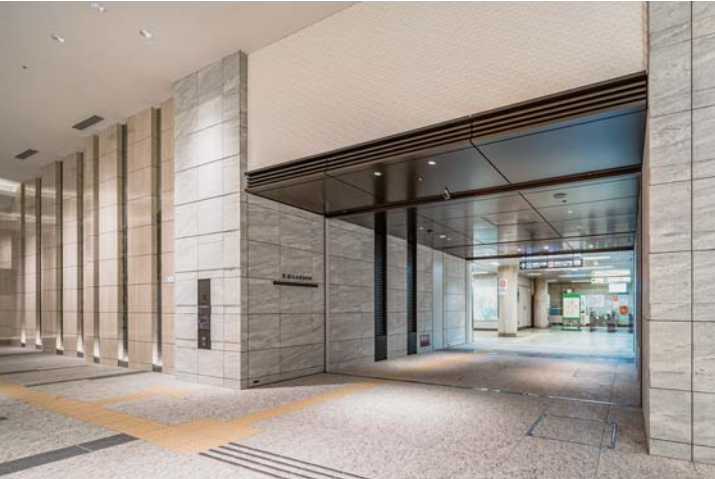
都営三田線春日駅改札との接続部
