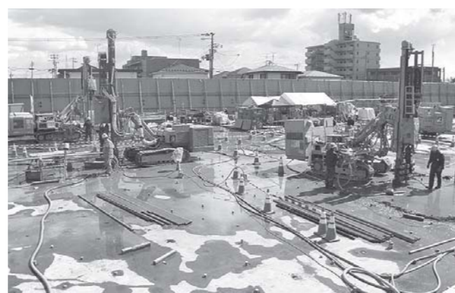
大規模開削の底盤改良
