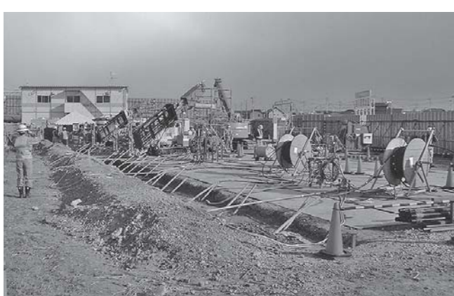
既存構造物直下の液状化対策
