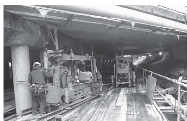
狭隙箇所の施工
