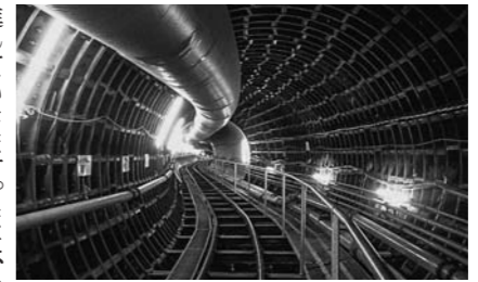
下水道局による市町村への下水道指導業務を開始し、豊富な知識や経験、ノウハウを活用して技術支援体制の強化・充実を図りました。職員には、下水道の「トータルソリューションパートナー」になれるように期待しています。
