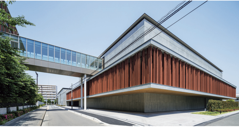
南西側からの外観
