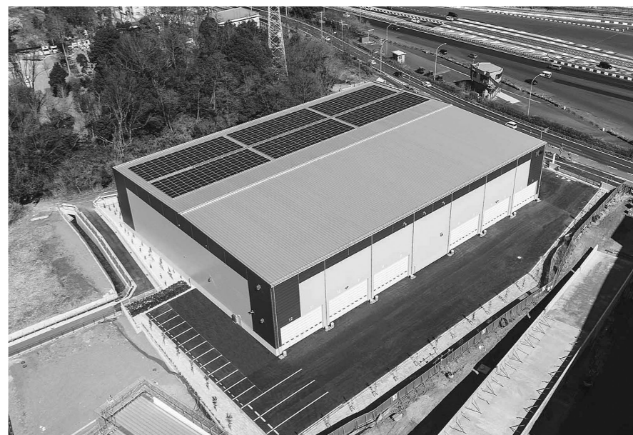
太陽光パネルを設置した屋根(写真提供: 関東建設工業)
