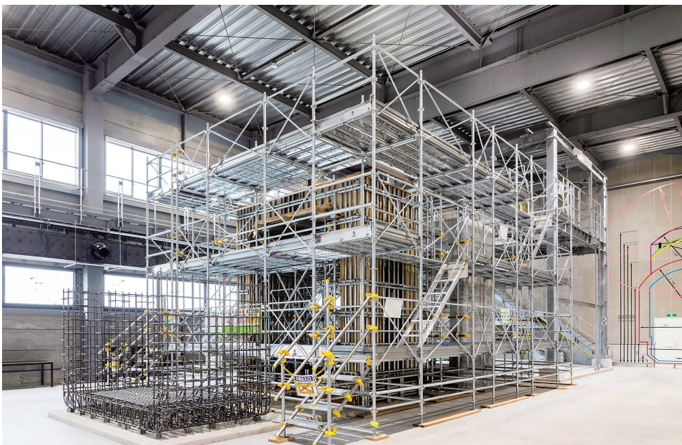
モックアップ（土木／ボックスカルバート）
