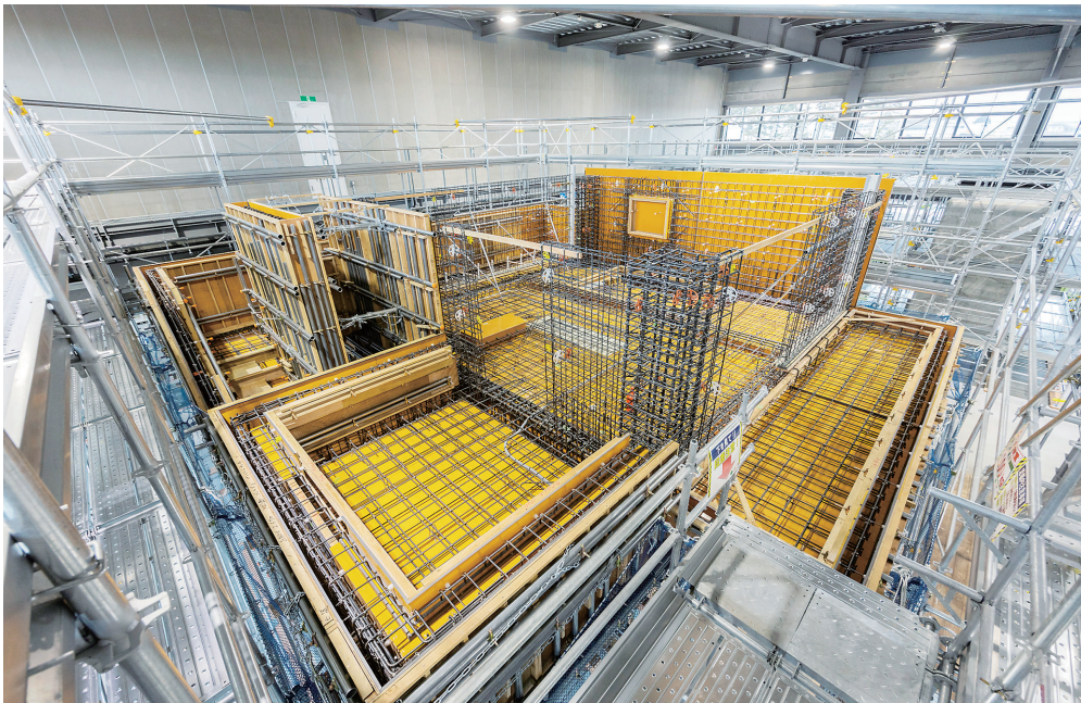
モックアップ（建築／鉄筋コンクリート造建物）
