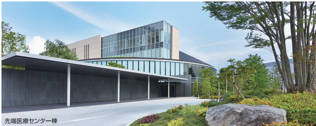
先端医療センター棟
