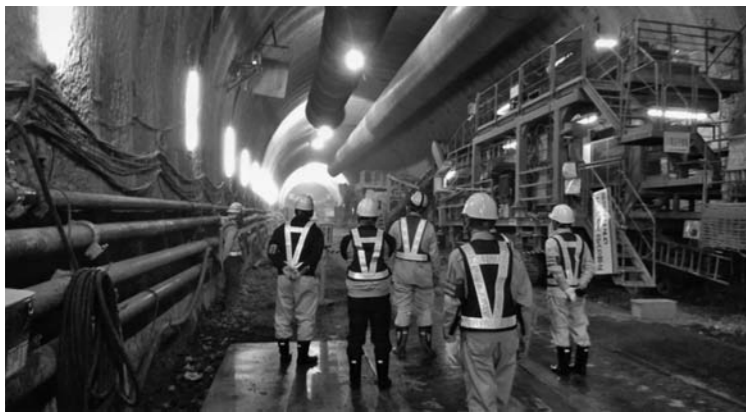
現場パトロールの様子
