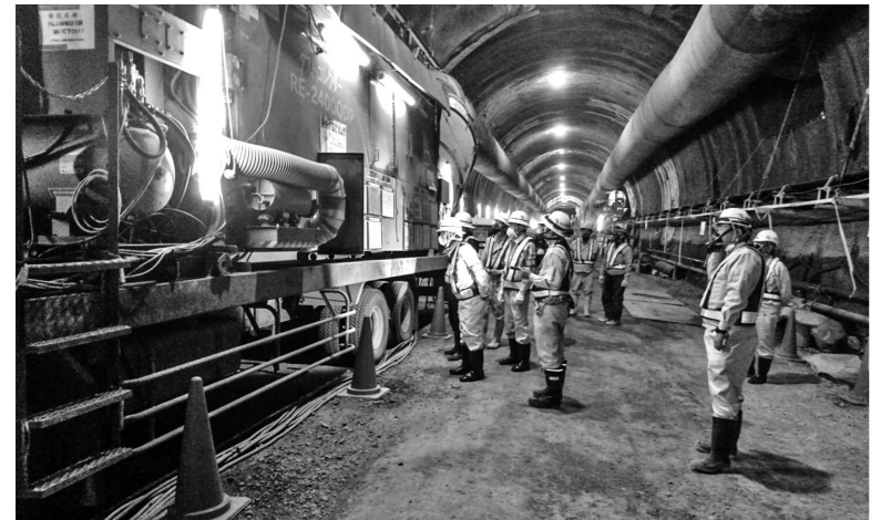
現場安全パトロール
