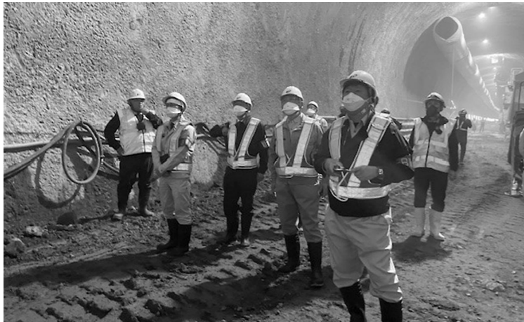
現場安全パトロールの様子
