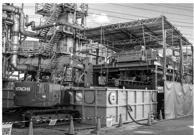
焼却施設を撤去・設置した仮脱水装置
