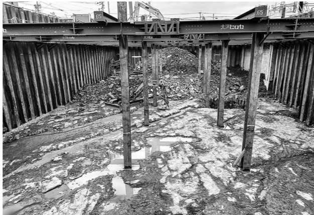
ポンプ棟の地下工事
