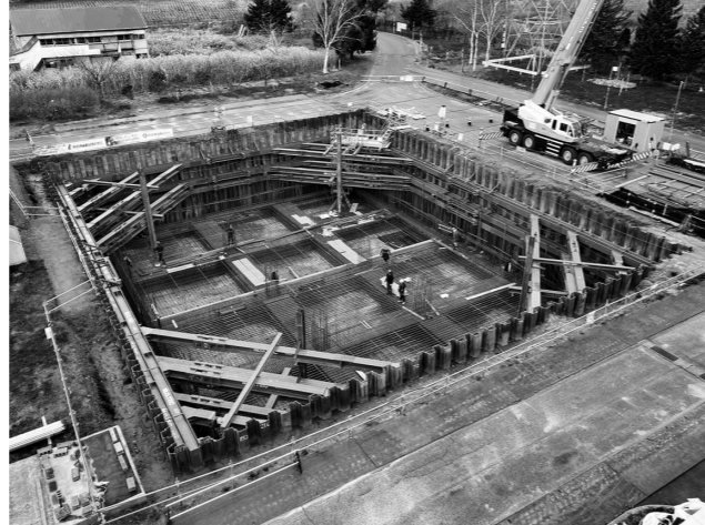
底板鉄筋組み立て状況
