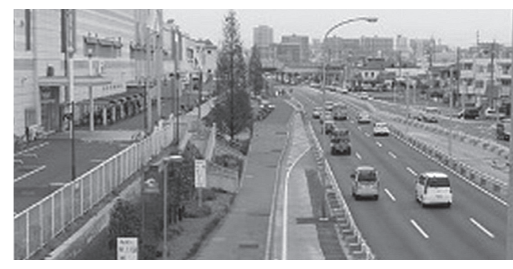
千葉県蘇我国道157号液状化対策工改良地盤:(B)(C) 地震後被害なし (施工:2004年10月~12月・撮影:2011年4月)
