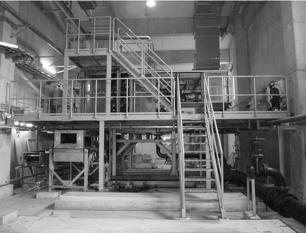
既設の汚泥脱水機設備
