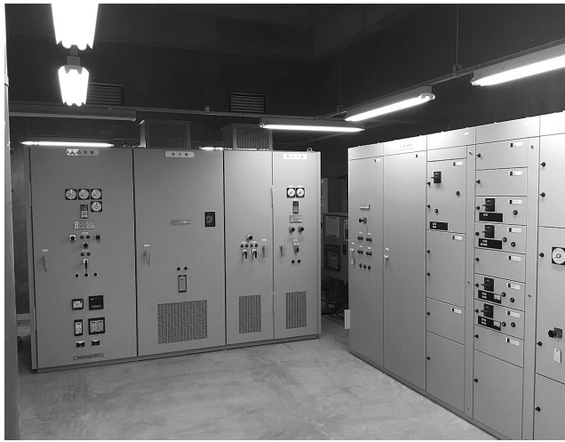
受変電・運転操作設備設置状況
