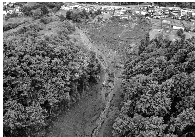
▲2019年東日本台風、八王子市内上恩方町①と下恩方町の土砂災害
