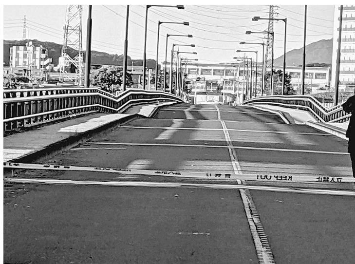
多摩川にかかる「日野橋」。19年の東日本台風によって橋脚が沈下し、路面に段差が生じた
