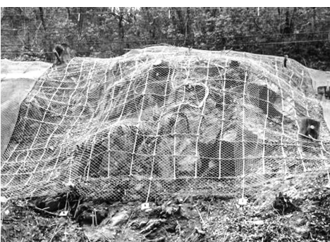
落石防護ネット工
