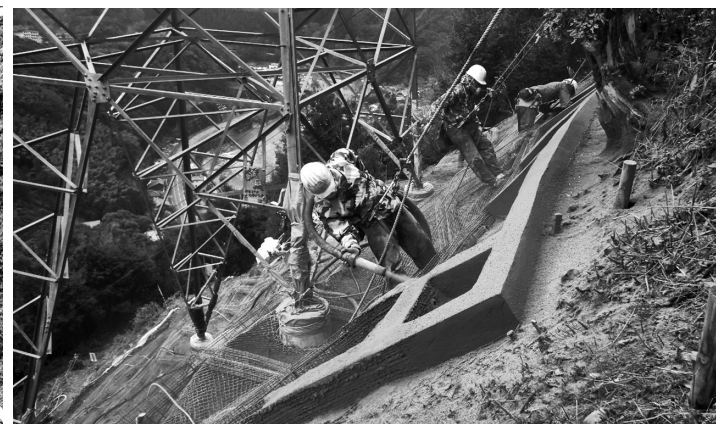
ファーストクリートDryの施工事例(ホース延長L=280m、高低差H=140m)
