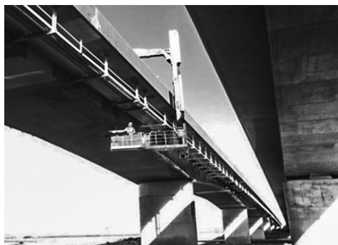
コンクリート表面剥離剥落対策工
