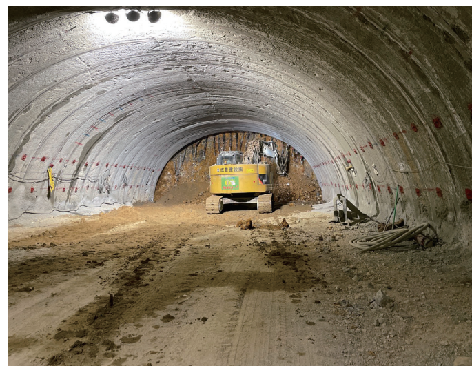
上半機械掘削状況
