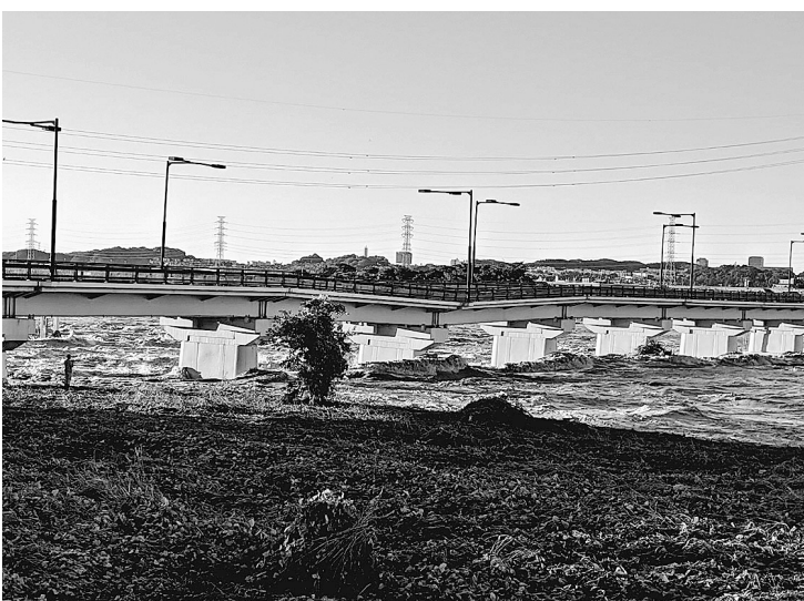
多摩川にかかる「日野橋」。19年の東日本台風によって橋脚が沈下し、路面に段差が生じた
