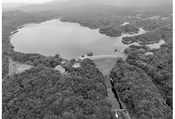
日本最大級のため池・満濃池 (まんのう町) (香川県土連撮影)
