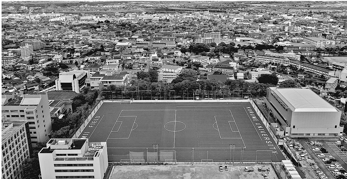
グラウンドを2m掘り下げて整備した
