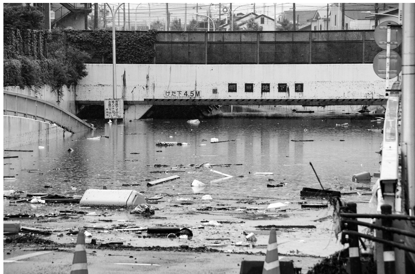
明田地下道の浸水状況
