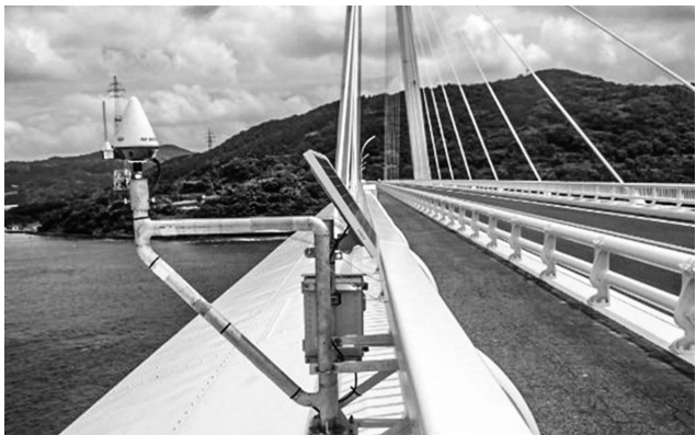
GNSS受信機の橋梁への設置状況
