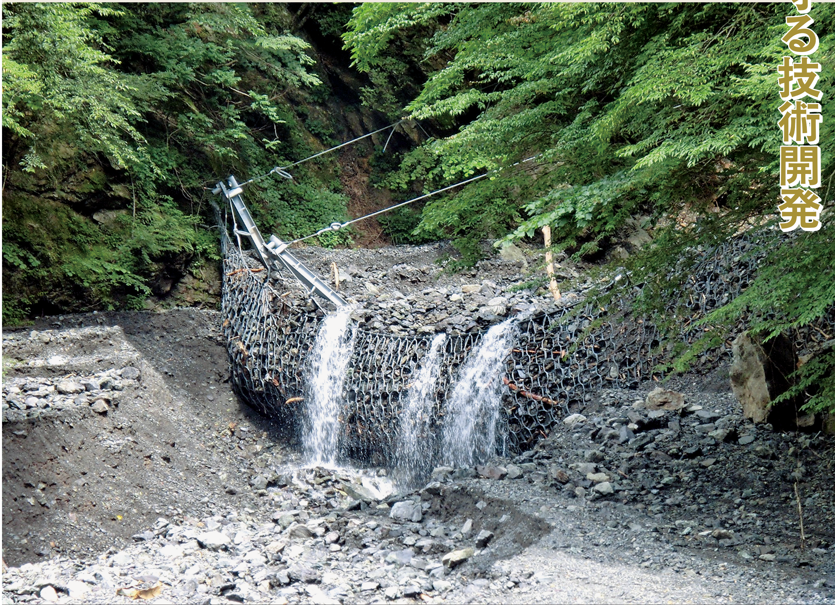
山梨県内に設置された安全対策工
