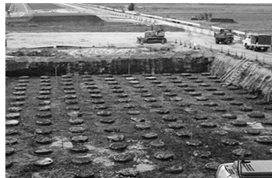
HL-DJM施工完了後の状況
