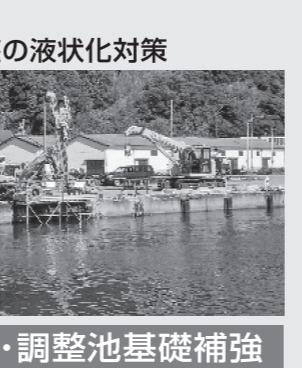
放水路・調整池基礎補強
