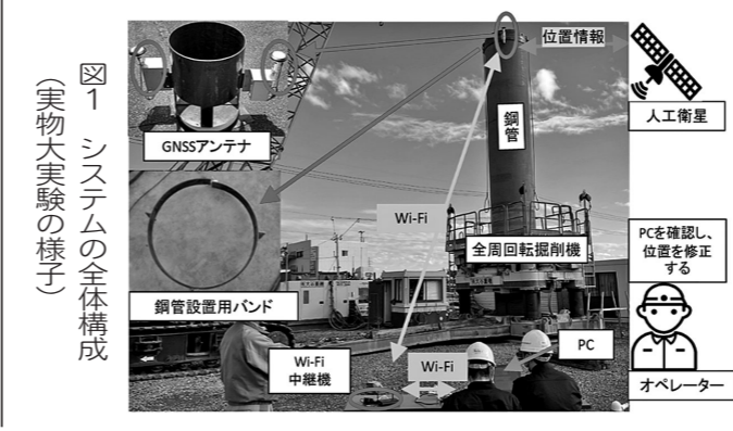
図1 システムの全体構成 (実物大実験の様子)
