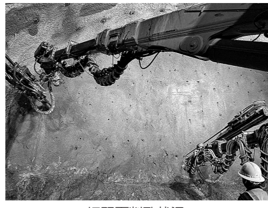
切羽面削孔状況
