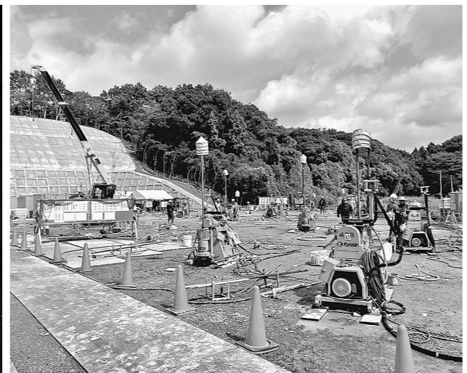
某電力施設工事での施工の様子
