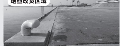
仙台塩釜港 改良地盤: 地震後被害なし(施工:平成19年 撮影:平成23年4月)
