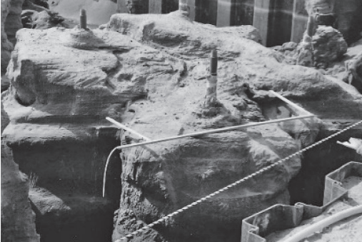
柱状浸透注入工法・エキスパッカ工法による低炭素グラウト「ハイブリッドシリカ」の高強度大径柱状連続固結体
