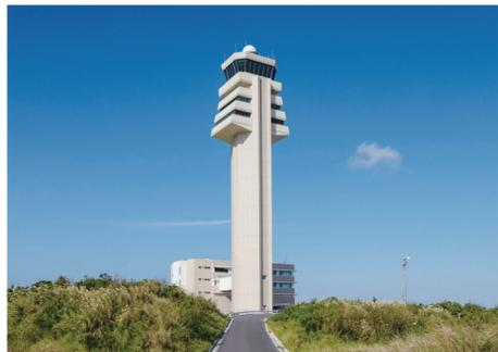
■建築主/国土交通省 大阪航空局 ■構造/【管制塔】RC・SRC・S造 【庁舎】RC造
