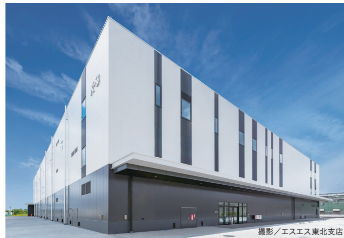
東京応化工業郡山工場新検査棟
