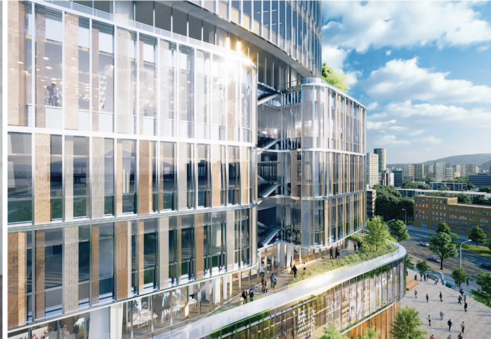
ガラスカーテンウォールを採用した曲線が特徴的な外装
