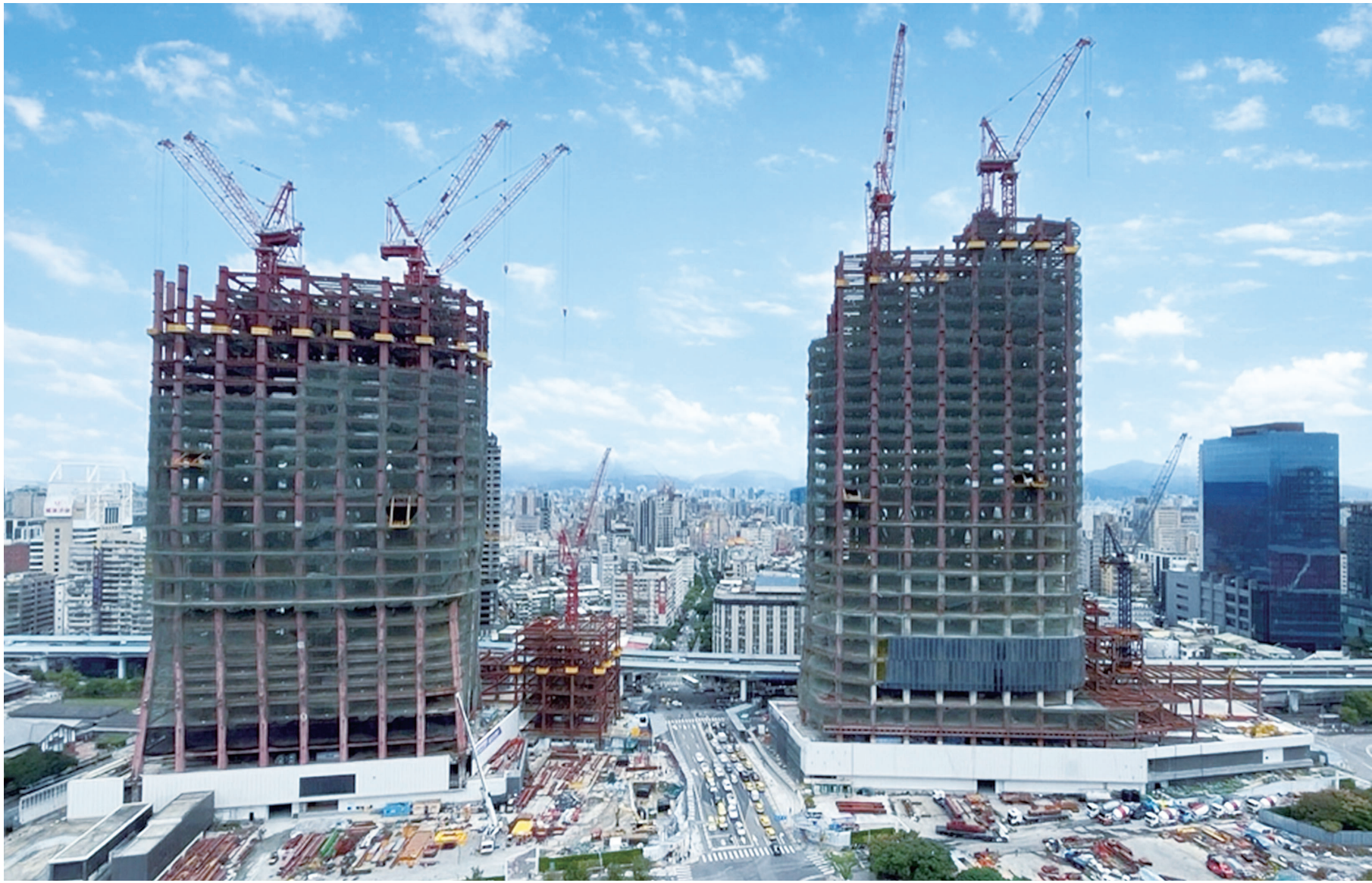
施工中の台北ツインタワー 11月末時点で鉄骨建て方は30階まで構築
