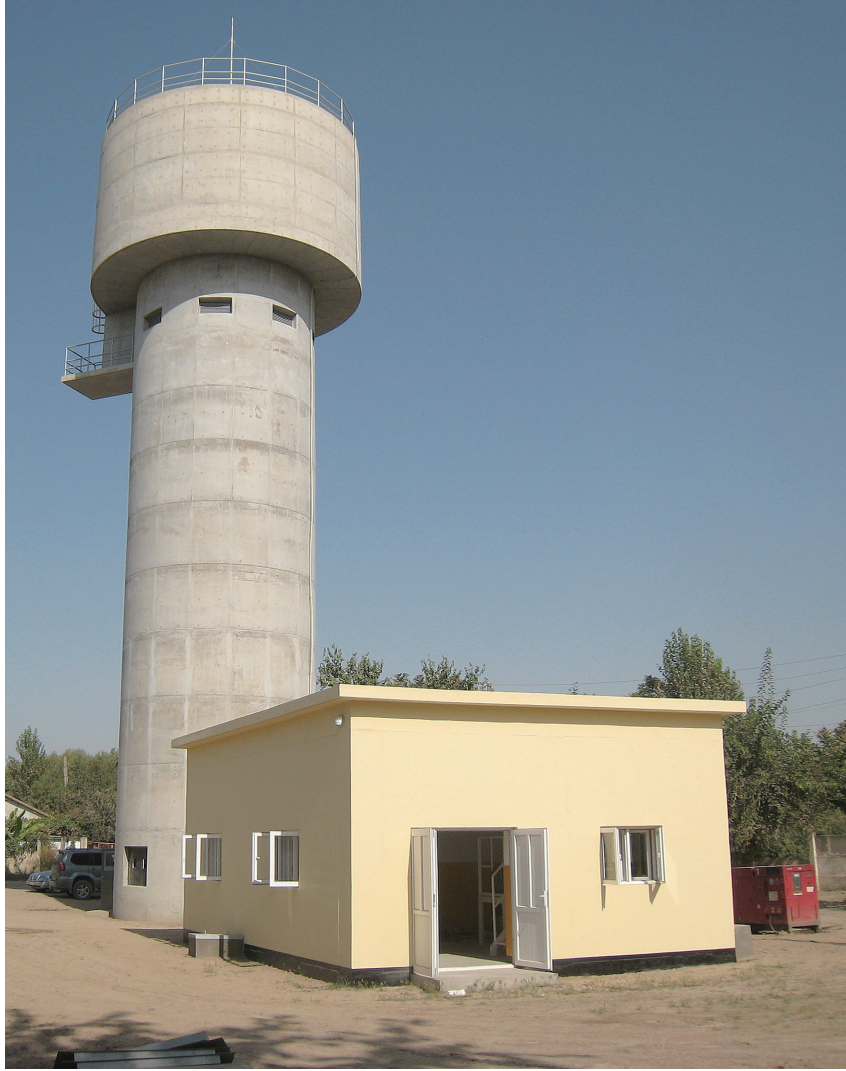
高架水槽（RC造、容量250㎡。ピアンジ県）
