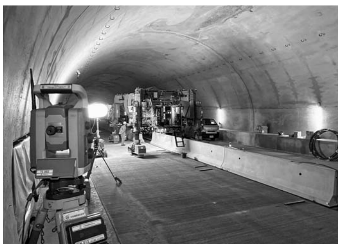
PCa 剛性防護柵据え付けの様子
