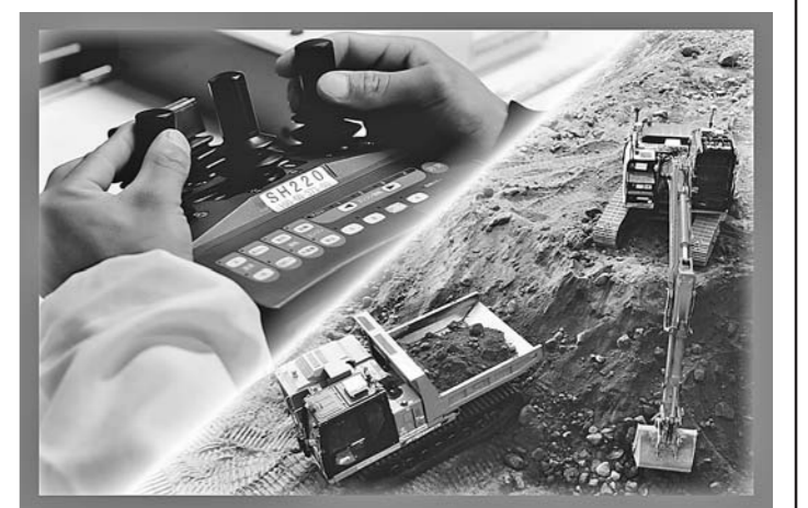
遠隔操作式重機による無人化施工の様子
