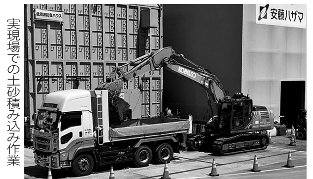
実現場での土砂積み込み作業
