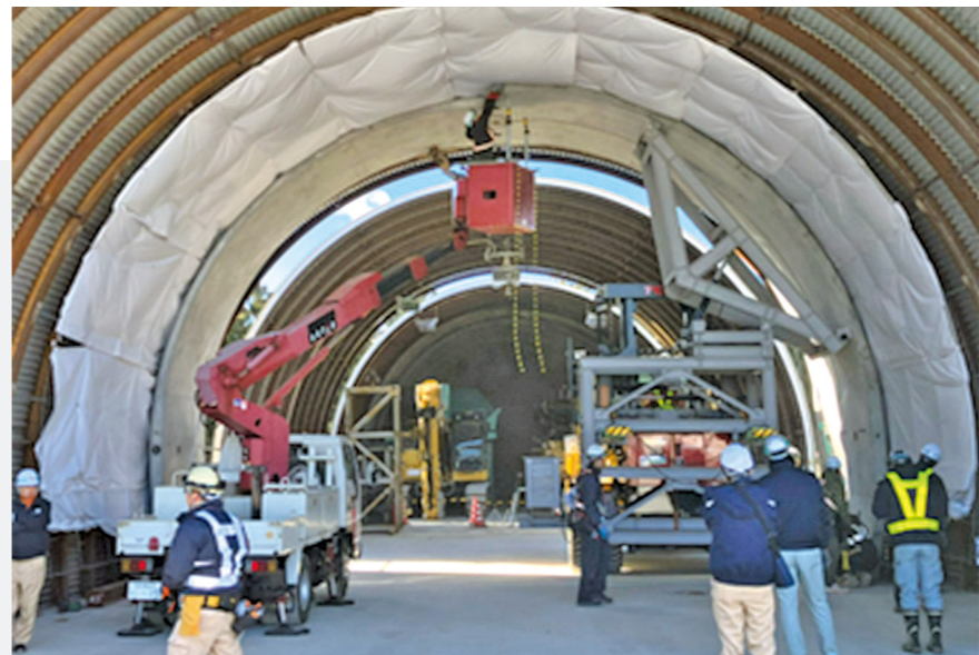
トンネル 西松建設らが模擬施設で実証した側壁一体型PC版と運搬・架設装置(報道発表資料から)
