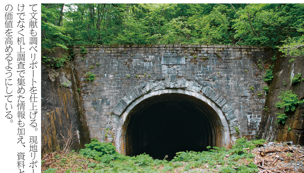
栗子山隧道が戦前期に改修を受けた、栗子隧道の坑口(平沼さん提供)
