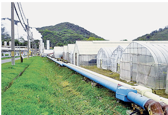
熱水を活用している森地熱発電所
