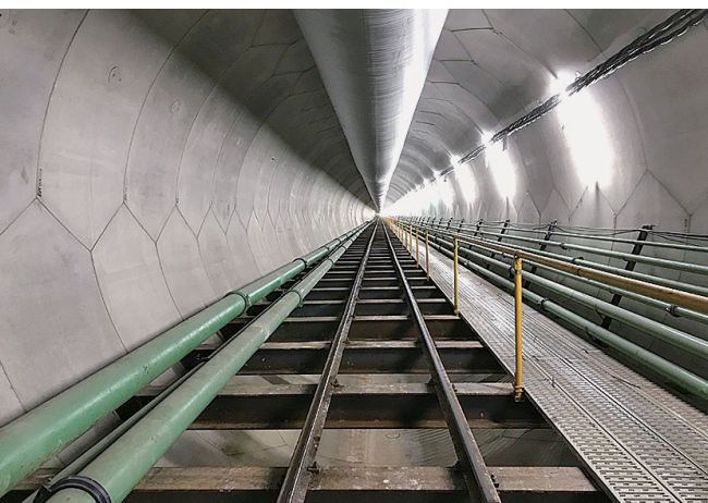
都心部を走る地下鉄よりさらに深い位置に造った千代田幹線(東京都下水道局提供)
