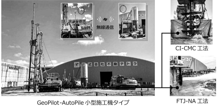
GeoPilot-AutoPile 小型施工機タイプ
