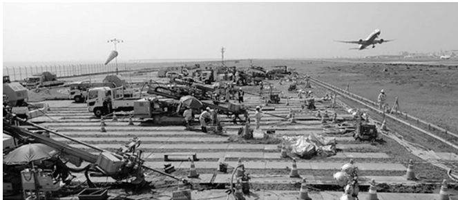
滑走路横からの曲がり削孔
