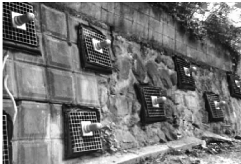
図2 ミニアンカーによる擁壁補強事例
