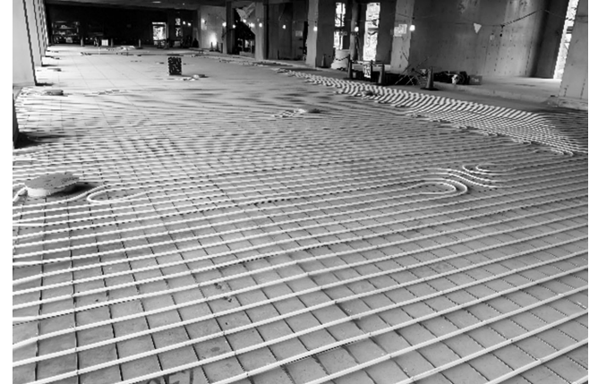
配管敷設状況
