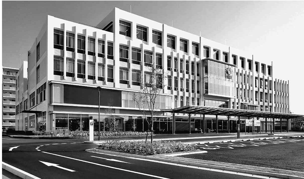
免震+PC圧着関節工法による病院建築
