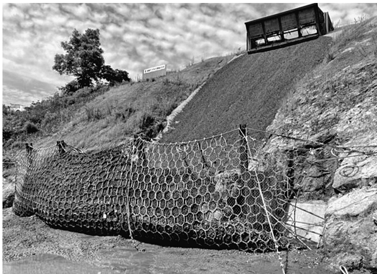
土砂実験実施状況
