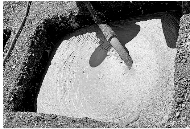
気泡混合軽量土打込み状況
