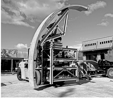
運搬・架設装置への側壁一体型 PCL版の積載状況
