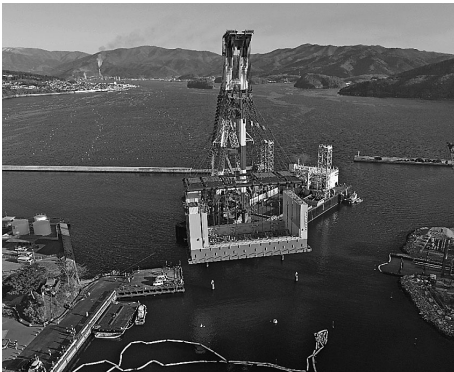
函体およびゲート本体据付状況
