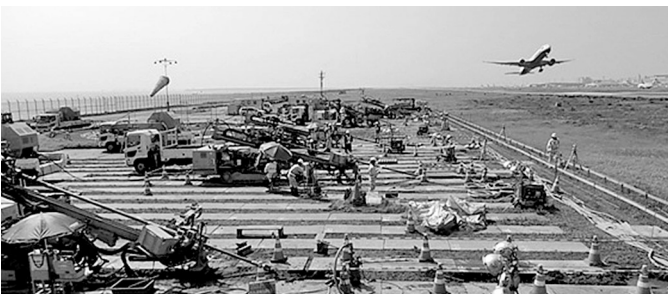
滑走路横緑地帯からの曲がり削孔
