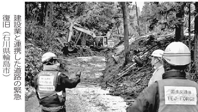
建設業と連携した道路の緊急復旧(石川県輪島市)
