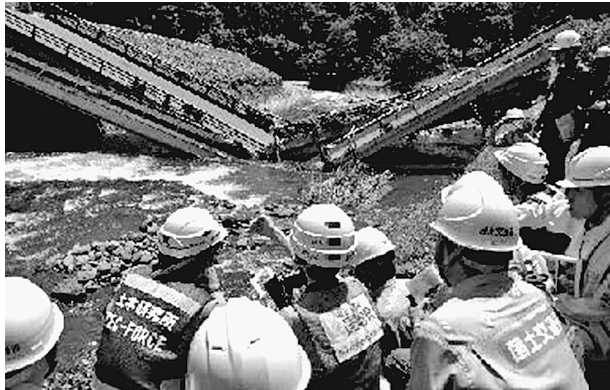
被災した県管理橋梁に高度技術指導(熊本県山都町)
