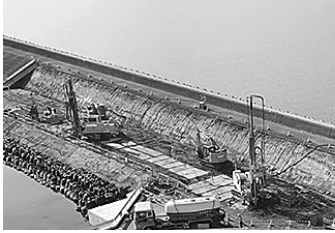
スマートコラム工法施工状況 (令和5年度八代海岸保全事業郡築工区堤防補強その2工事、受注者：アイサウ工業)
