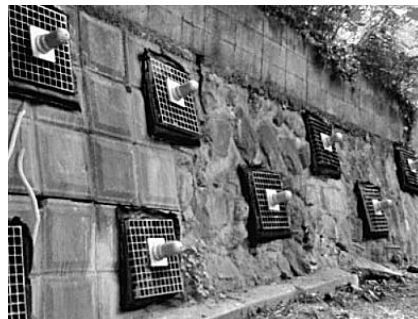
図2 ミニアンカーによる擁壁補強事例
