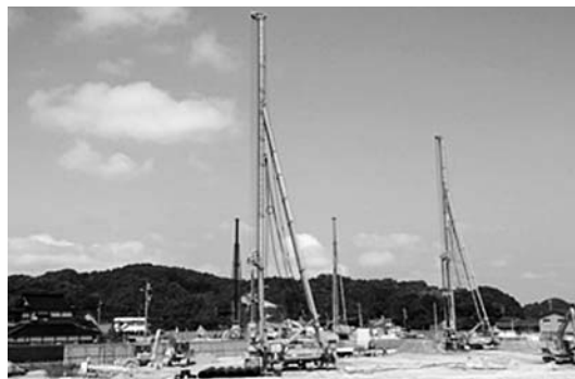
HL-DJM施工状況(水見高岡自動車道)
