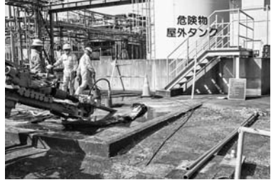
既設構造物直下地盤への適用事例
