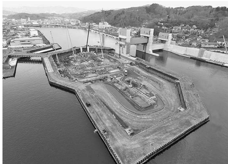
水門新設工事
