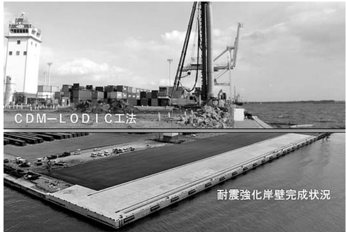
CDM工法を岸壁の本体工として適用 三河港神野地区岸壁(—12m) 本体工事
