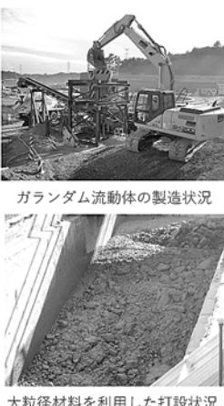
大粒径材料を利用した打設状況
