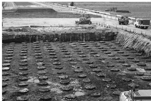
HL-DJM施工完了後の状況
