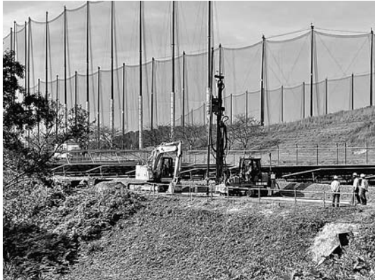
調整池水面を対象とした試験施工 (スマートコラム施工機)
