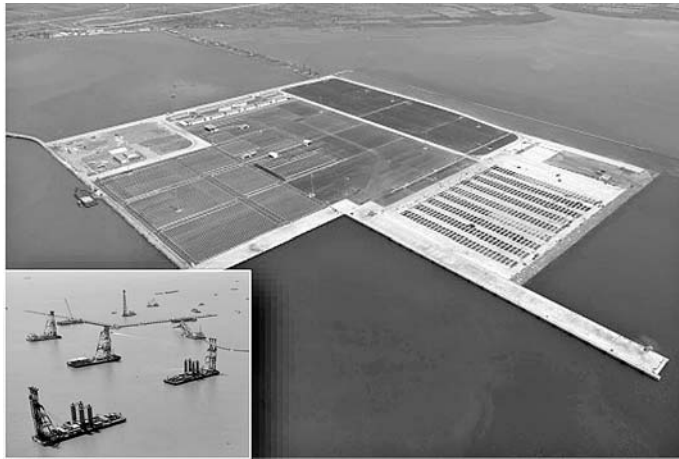
パティンバン港ターミナル建設工事 インドネシア
