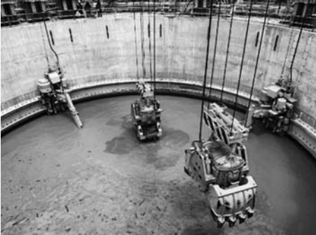
橋脚基礎 (φ4.0m) への適用事例 角島大橋 (山口県下関市)
