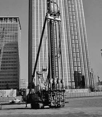
DCM-L工法(4軸機) 設計基準強度5,000kN/m 2 に対応
