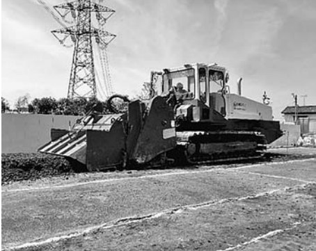
混合攪拌機による地盤改良土の生成状況
