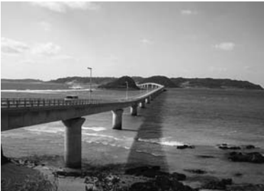
橋脚基礎 (φ4.0m) への適用事例 角島大橋 (山口県下関市)
