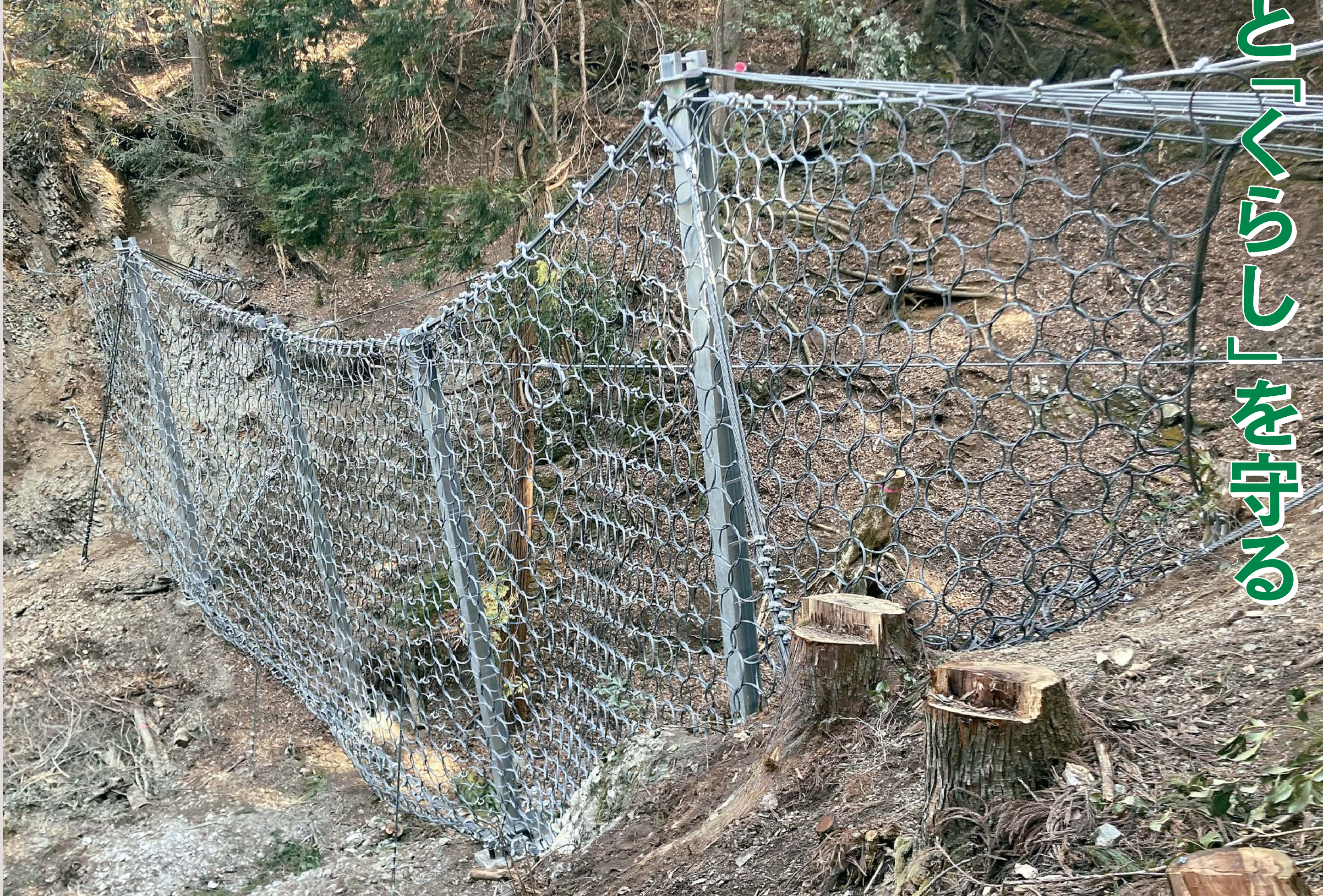
岐阜県内に設置された安全対策工
