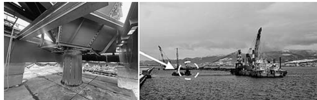
カルシア落下混合船と自立式スリットトレミーを使用した施工状況
