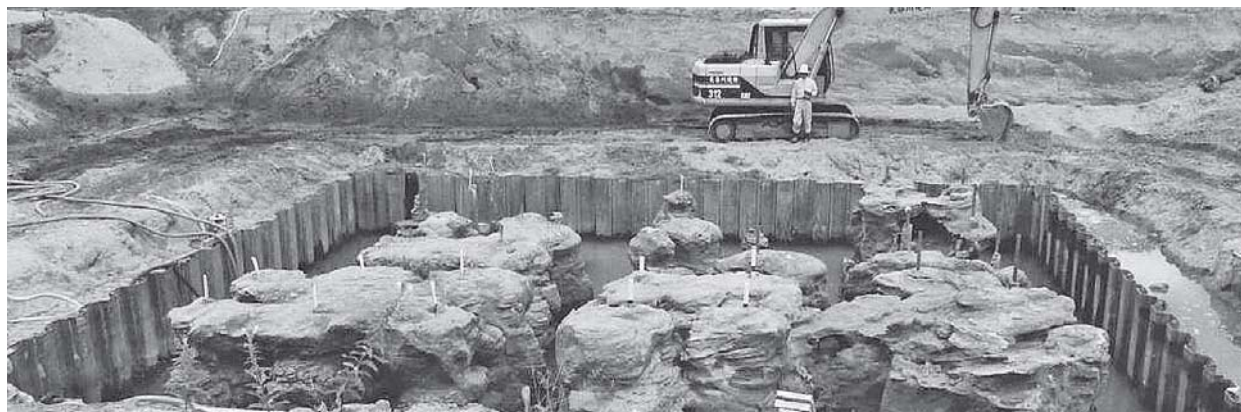
写真1 1999年産学協同研究による大規模野外試験(株ADEKA鹿島工場敷地(神栖市))
