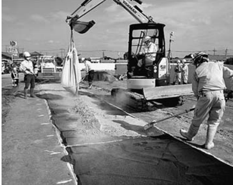
溶融スラグ、バイオ炭、セメント系固化材の敷きならし状況
