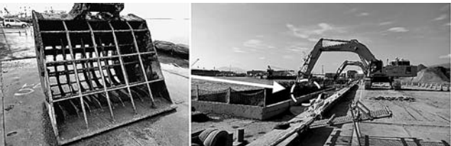
カルシアパケットを装着したバックホウ混合の施工状況
