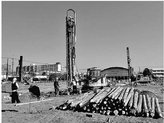
LP-LiC工法の施工状況
