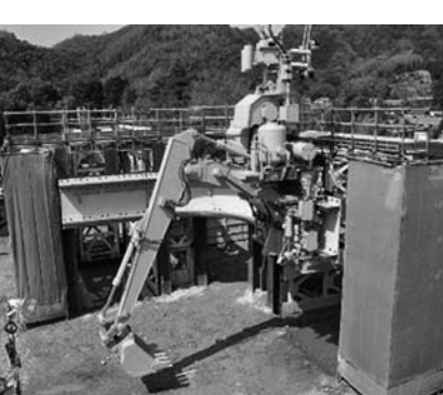
掘削揚土状況、水中掘削機本体
