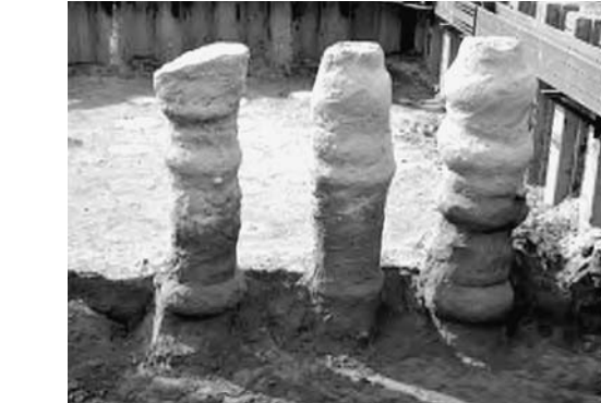
締固め固化砂杭の掘出し（自立確認）
