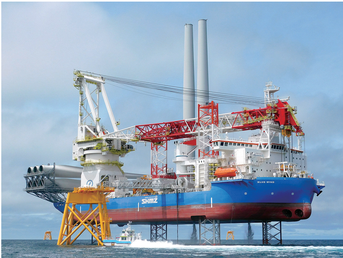
清水建設のSEP船が北海道・石狩湾新港沖で洋上での風車据え付け作業に着手した(7月14日撮影)
