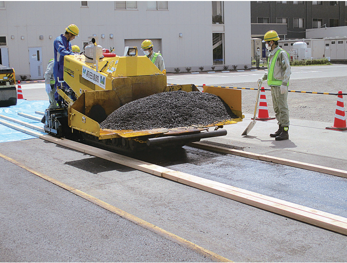
水素バーナーで製造した合材で試験施工
