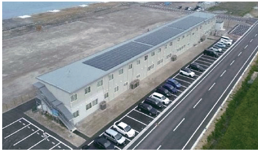
五洋建設が現場事務所のZEB化を加速(北九州響灘洋上ワインドファーム建設工事、報道発表資料から)
