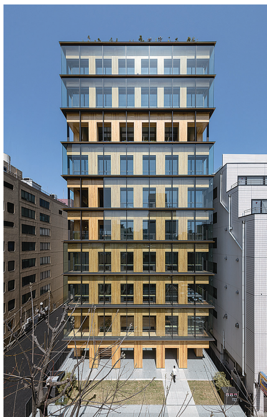
Port Plusの外観(大林組提供)
