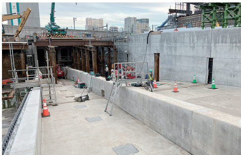
鉄道線路直下での難工事だ (第二東西連絡道路)
