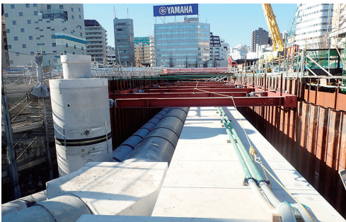
インフラ整備の一環で 下水道工事も手掛けた
