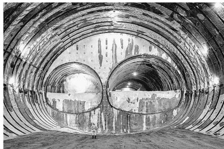
世界最大級の掘削断面積485㎡の達成状況
