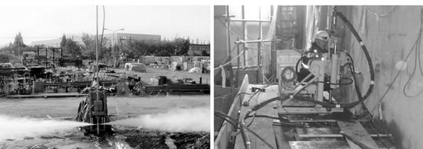
2方向噴射状況 狭い箇所での施工事例
