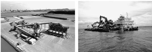
建設発生土の有効利用先として注目される東京湾浅場造成事業 (左:専用プラントによる粒度調整、右:埋立材料の海中投入)
