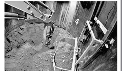
掘削機による排土システムへの積み込み
