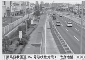
千葉県蘇我国道157号液状化対策工 改良地盤:(B)(C)地震後被害なし(施工:2004年10~12月・撮影:2011年4月)
