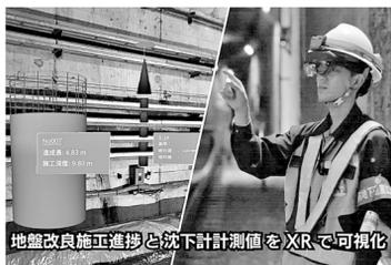
システム利用状況。円柱が施工位置と進捗、矢印が構造物の鉛直変位量・方向を示している
