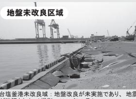
仙台釜釜港未改良地盤:地盤改良が未実施であり、地震後陥没が確認された。(撮影:2011年4月)
