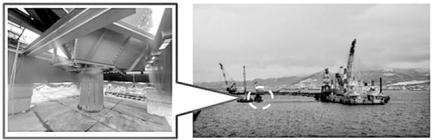
カルシア落下混合船とスリットトレミーを使用した施工状況
