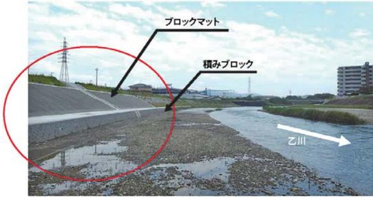
22年度に実施した護岸工事現場(通常製品を使用)。積みブロックは傾斜が急な護岸に、ブロックマットは傾斜が緩やかな護岸に使用(報道発表資料を基に作成)
