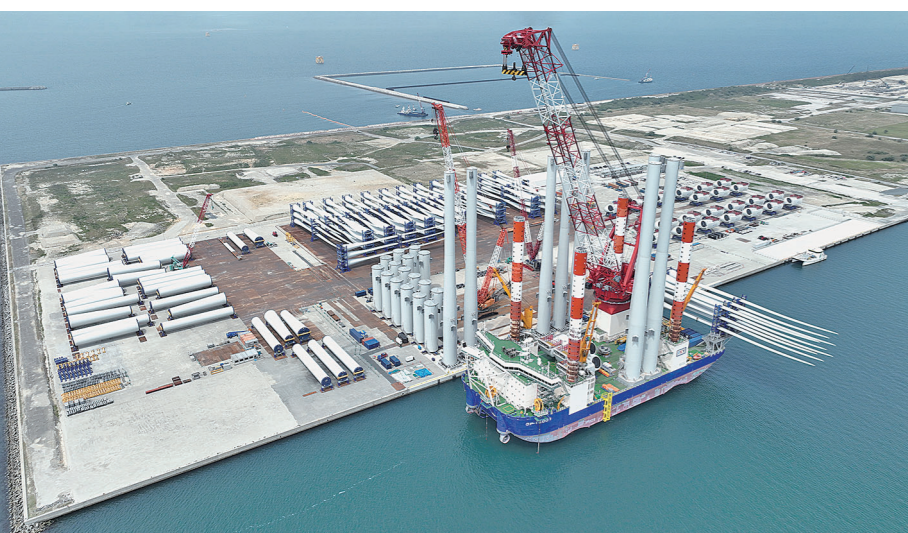
風車部材を積み込み
