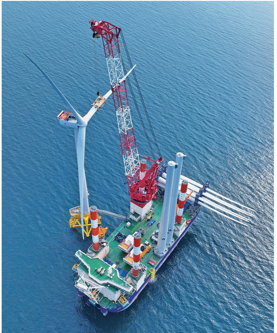
風車ブレードの据え付け
