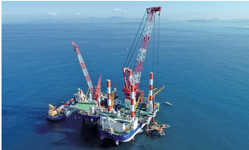
作業船3隻体制での基礎工
