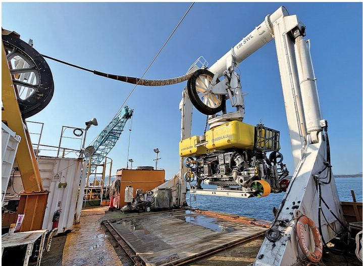
ケーブル埋設 (ROV埋設機)
