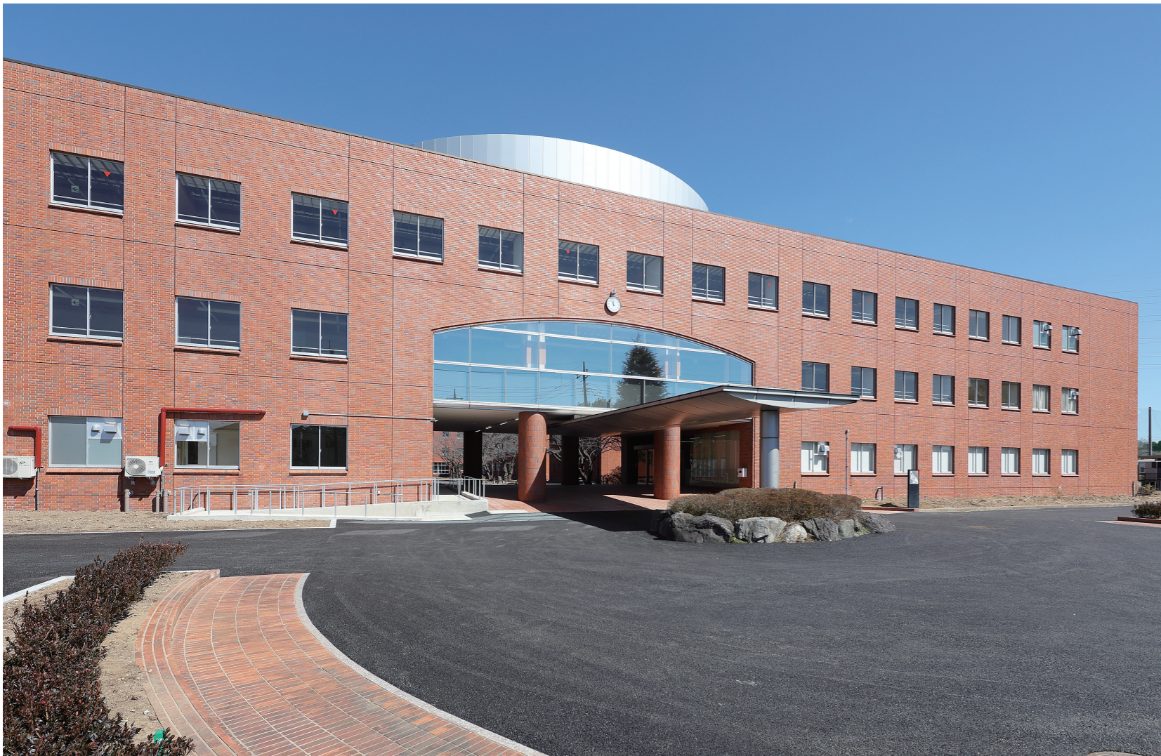
設計・監理／奥野設計 施工／新日本建設
