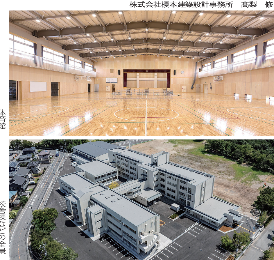
校舎棟などの全景
