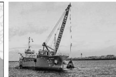
ガット船による石材投入作業
