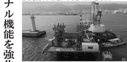
海上橋脚基礎の現地載荷試験(大阪湾岸道路西伸部)
