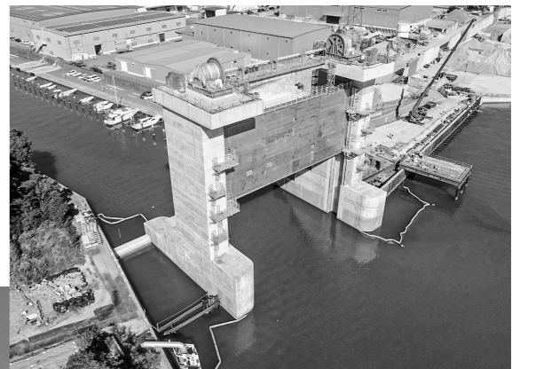
和歌山下津港海岸の日方水門と護岸
