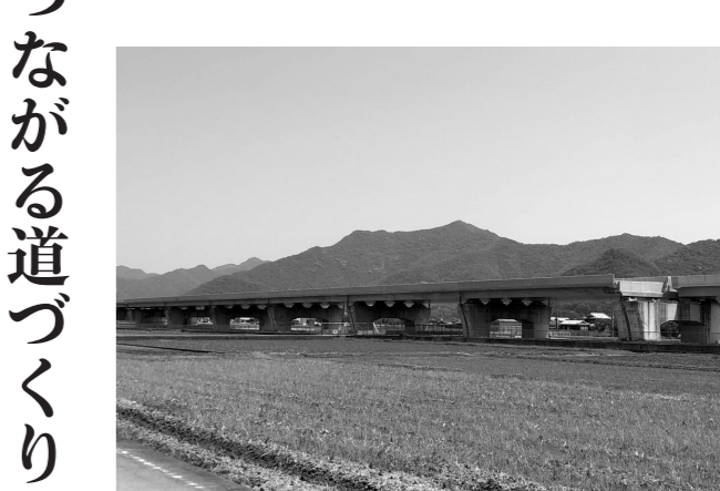
西脇北B P津万高架橋
