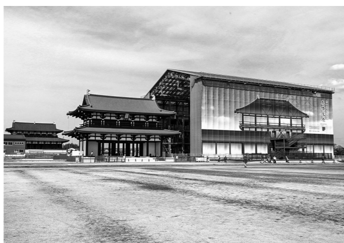
完成した大極門と施工中の東楼
