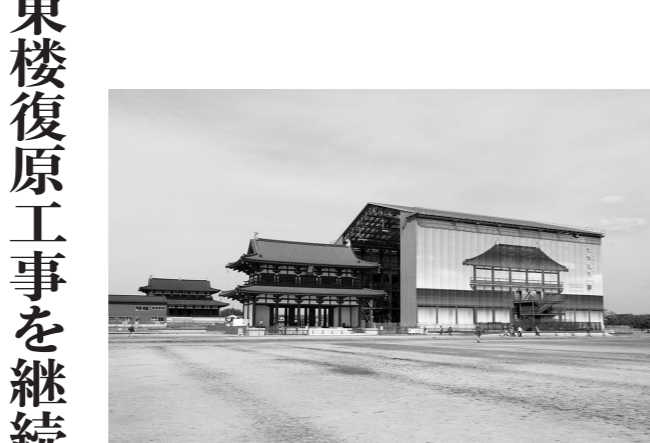
完成した大極門と施工中の東楼
