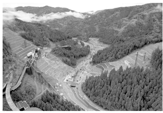
ダム本体のコンクリート打設状況
