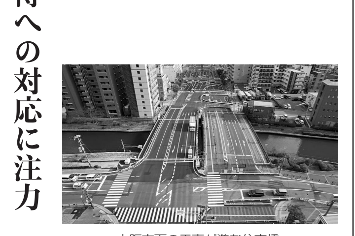
大阪方面の工事が進む住吉橋
