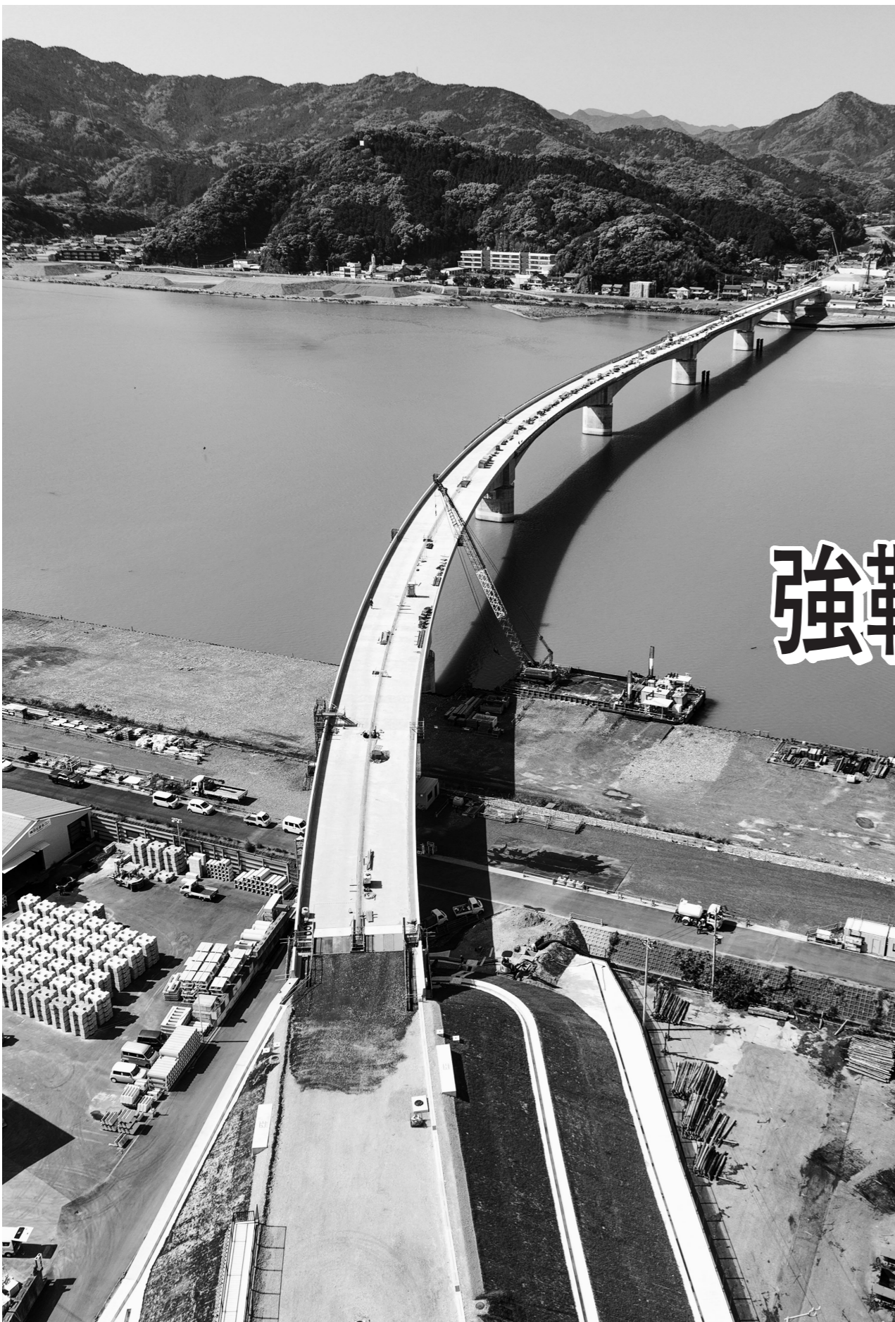
新紀伊道路熊野川河口大橋
