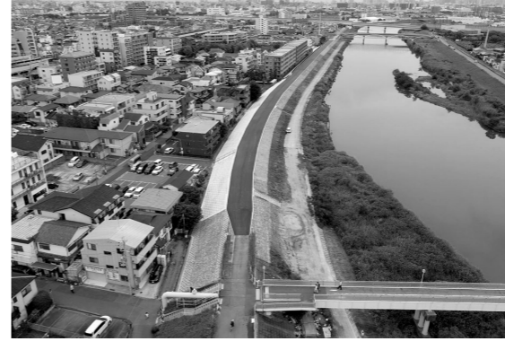
堤防の拡幅工事などが進む島の内地区
