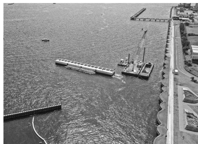
基礎捨石投入状況(2023年4月5日撮影)
