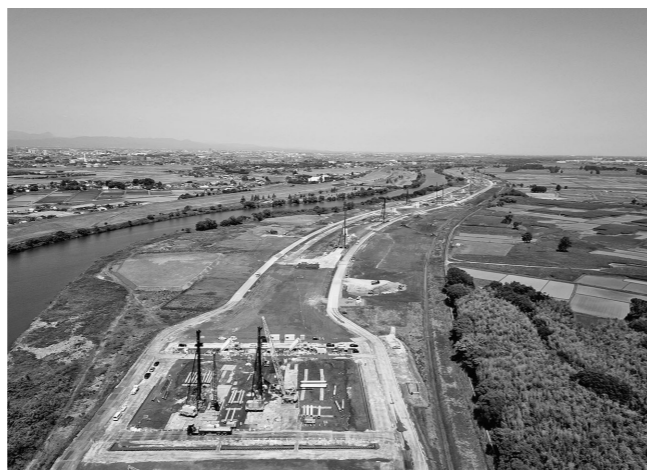
現場全景(排水門工事箇所から荒川上流を望む)
