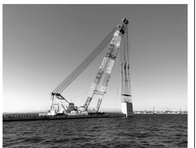
ケーソン据え付け
