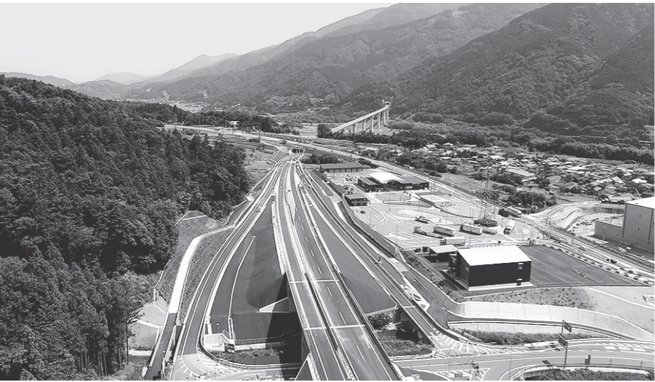
写真提供:関東地方整備局 道路部
