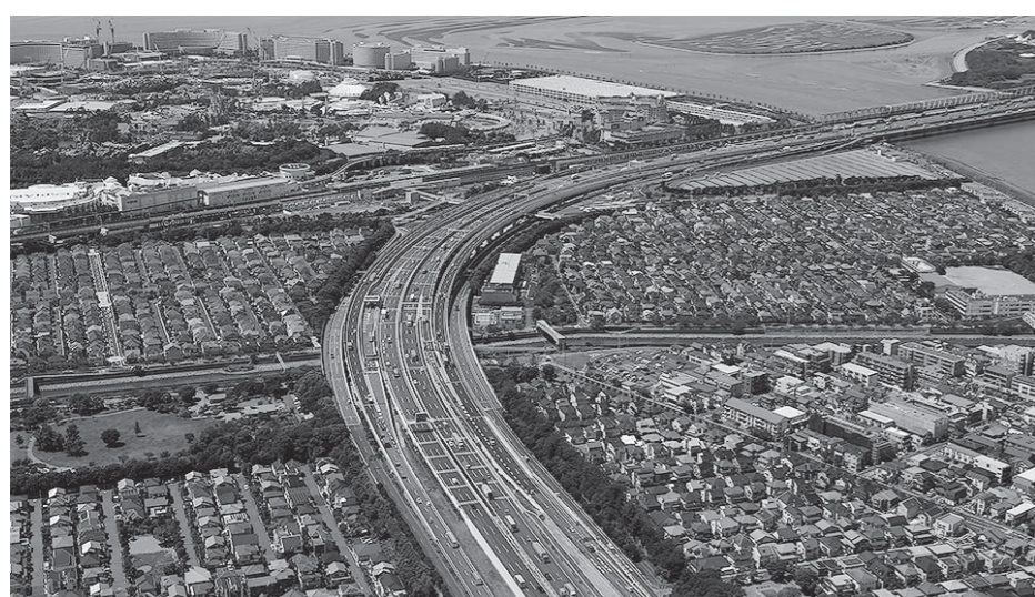
写真提供:関東地方整備局 道路部
