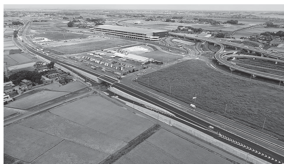
写真提供:関東地方整備局 道路部
