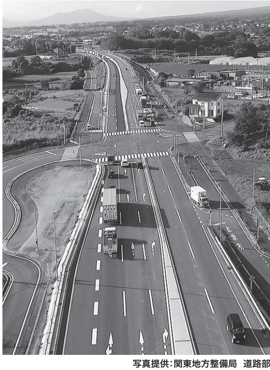
写真提供:関東地方整備局 道路部
