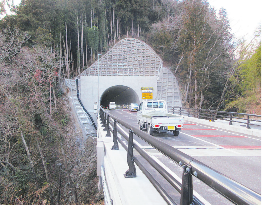
大張ウソコトンネル終点側付近
